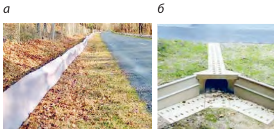
Рис. 127. Заградительное сооружение: а) возле автомобильной дороги; б) тоннель для лягушек
