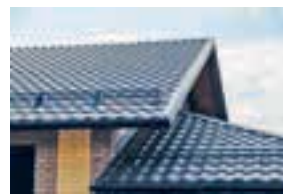
Палімернае пакрыццё на металічнай чарапіцы
